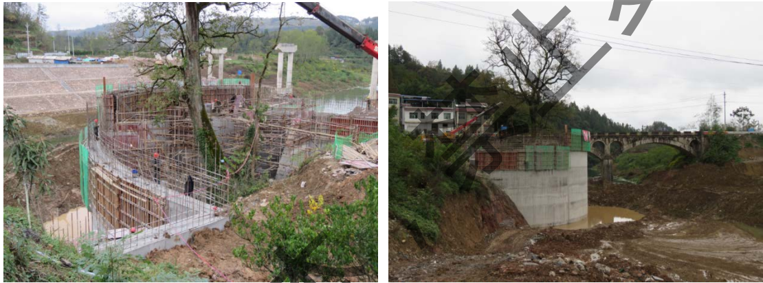
红心桥附近古树防护工程整在进行施工
