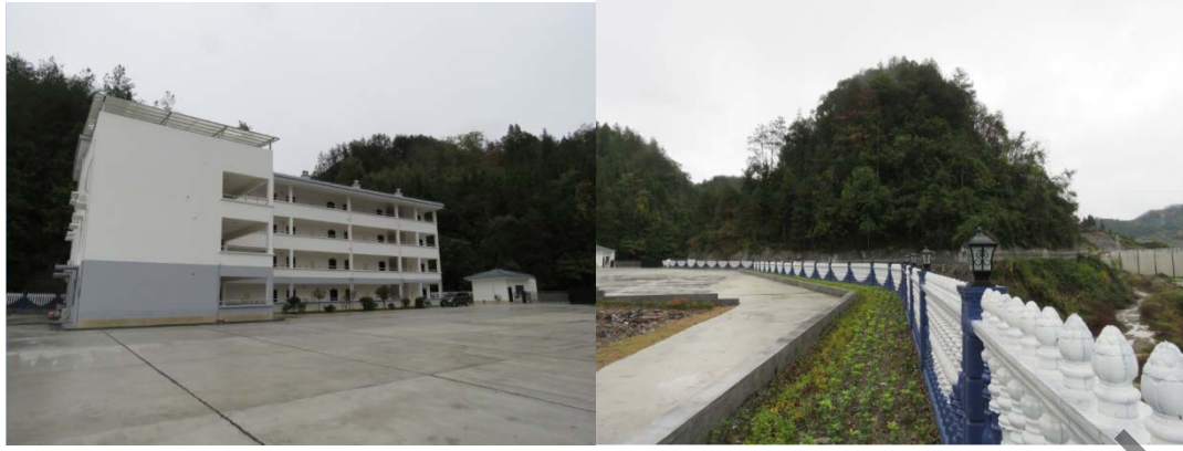
施工生产生活区
