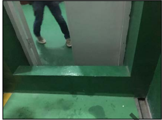
油罐区进门处门槛
